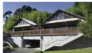
温泉やウッドデッキを備えたバンガロー
