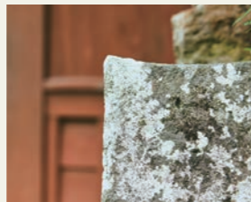
切り石のカドが少し尖っている。琉球にも見られる石垣の「隅頭石」。
